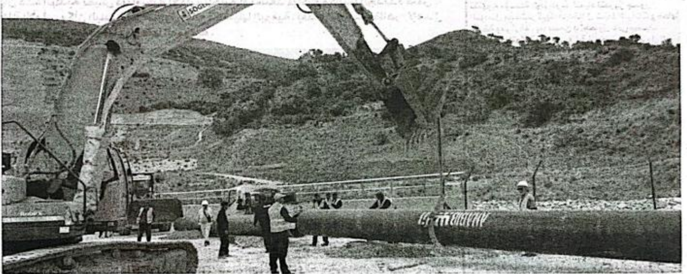
الانطلاق أشغال الربط بسوق أهراس
